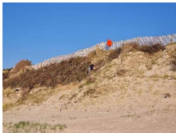
Figure 136 : Pose des branchages
