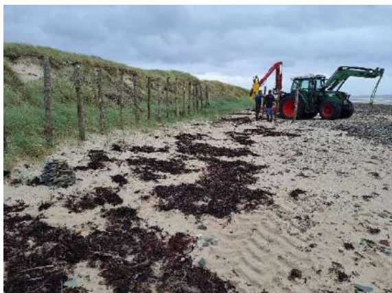
Figure 132 : Installation des poteaux pour les fascines
