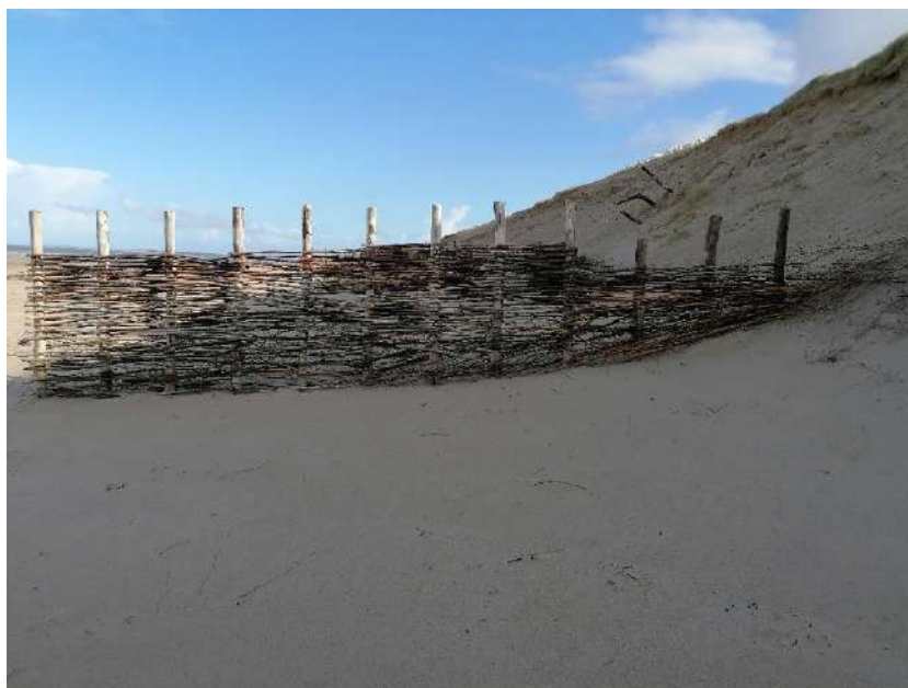
Figure 124 : Reconnexion de la fascine P6
