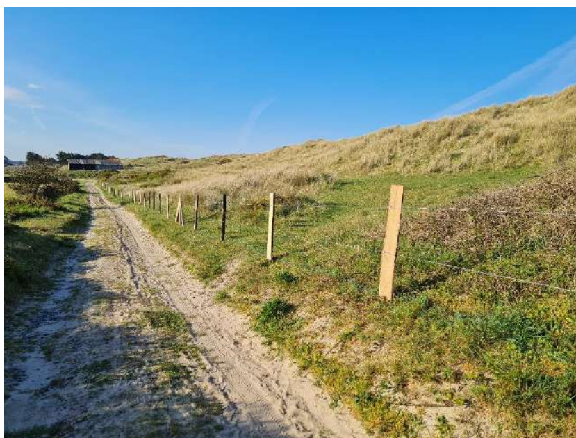
Figure 125 : Pose de la clôture
