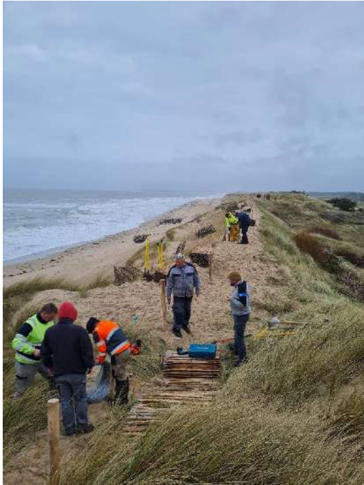
Figure 126 : Chantier de pose de ganivelles - Pirou février 2022
