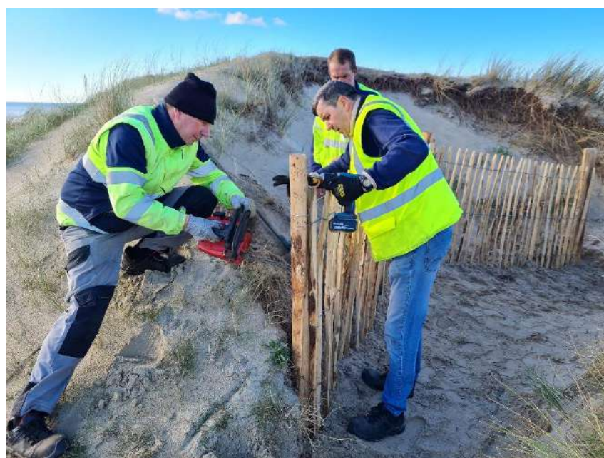
Figure 115 : Pose de ganivelles face à la charrière
