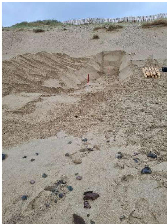
Figure 117 : Implantation des fascines
