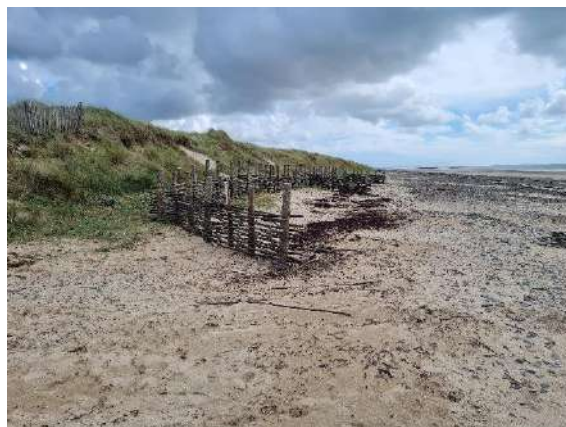
Figure 133 : Ensemble des fascines au sud de la cale
