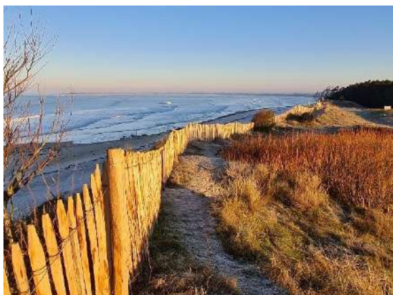
Figure 135 : Ganivelle installée
