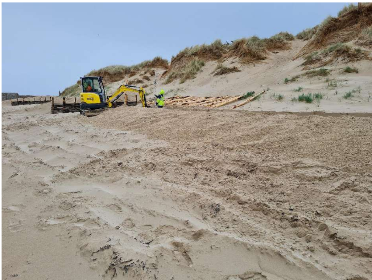
Figure 116 : Implantation des fascines
