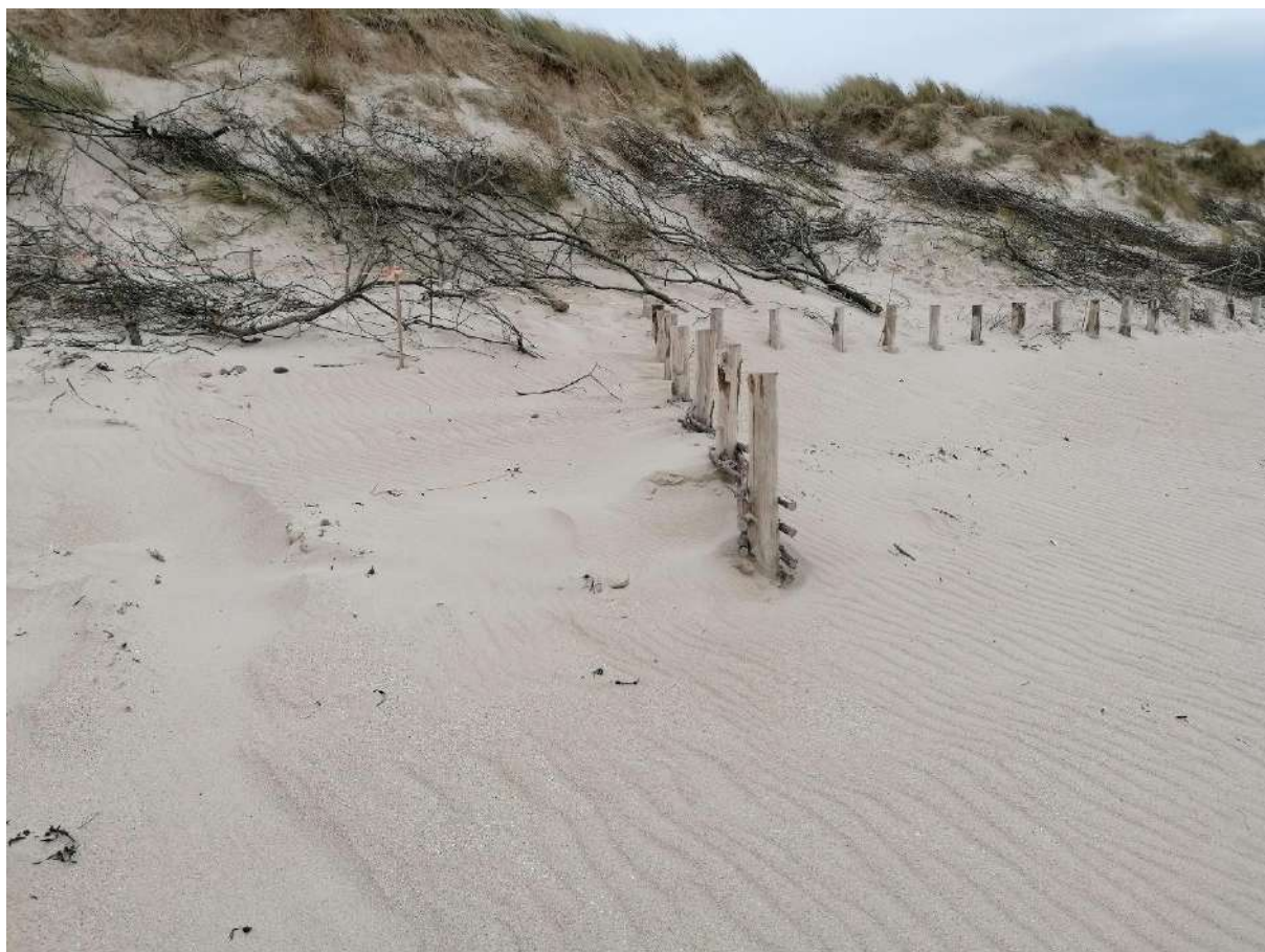
Figure 119 : 16 mars 2023 au niveau de la fascine C1
