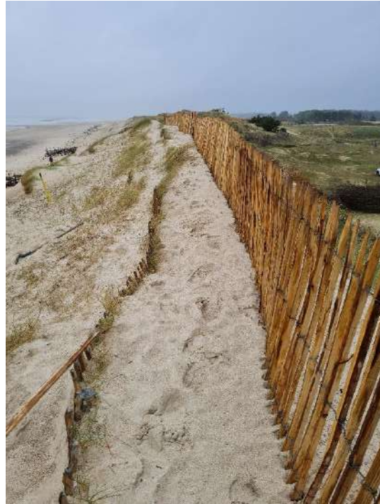
Figure 127 : Ganivelles posées
