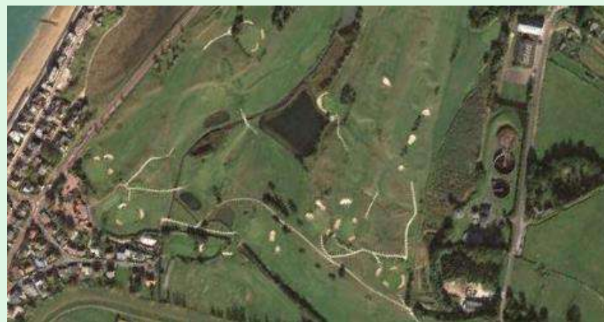
Figure 72. La station d'épuration d'Agon-Coutainville, située en zone d'aléa fort à 20 ans (capacité 35300 EH) – Source : Google Earth
