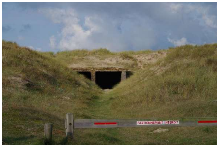
Figure 13 : Ouvrage dans le cordon dunaire à Surtainville (source : Antea, 2017)
