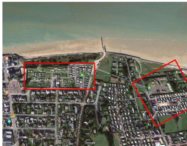
Figure 69. Campings de Hauteville-sur-Mer derrière la digue
